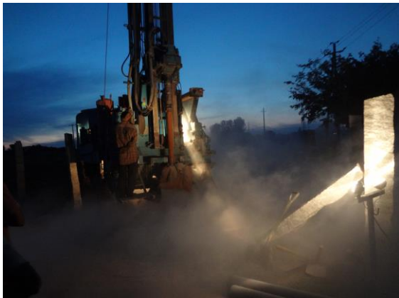
Brunnen-Bohrungen bis in den Abend hinein
